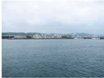
串本港内に到着。正面に見えるのが円形の油タンクに大きく赤枠で囲って「漁連」と書いてある漁連が経営する給油施設。
