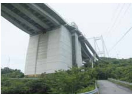
橋脚の中にエレベーターがあり大橋に行けます。
