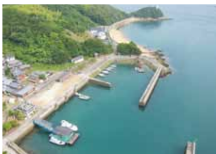
来島海峡大橋から約60m下の港を見下ろしています。
