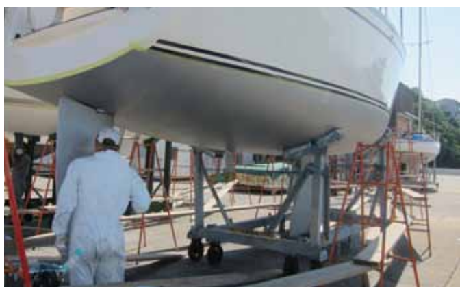
サンディング終了後ウエスとアセトンで汚れと油分を除去してキール部分から塗装が始まりました。キール部は020防蝕プライマー2回塗装、そして013 FRP用エポキシプライマーを2回塗装しています。
