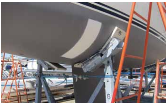
塗装中に船台に当たっていた部分は入念に作業を行っていました。塗装作業が終了して2日後にクレーン作業で船台に当たる部分を変え、他の部分と同じ工程で塗装作業を行いました。
