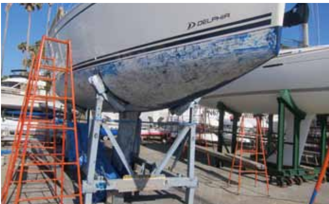
昔から使われている鉄製のスクレッパーでコツコツと剥がしています。ブルーシートで受けを作り下のコンクリート地面が汚れないように工夫しています。
