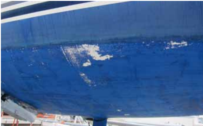
どこまで剥がれるかを知るために高圧洗浄機で洗ってみました。3年間で3回塗装したと言っていたのですが、下地まで出てしまいました。
